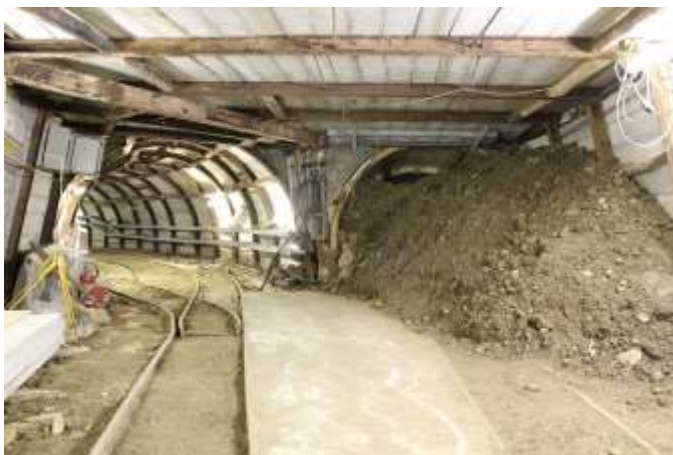
坑道充填状況
